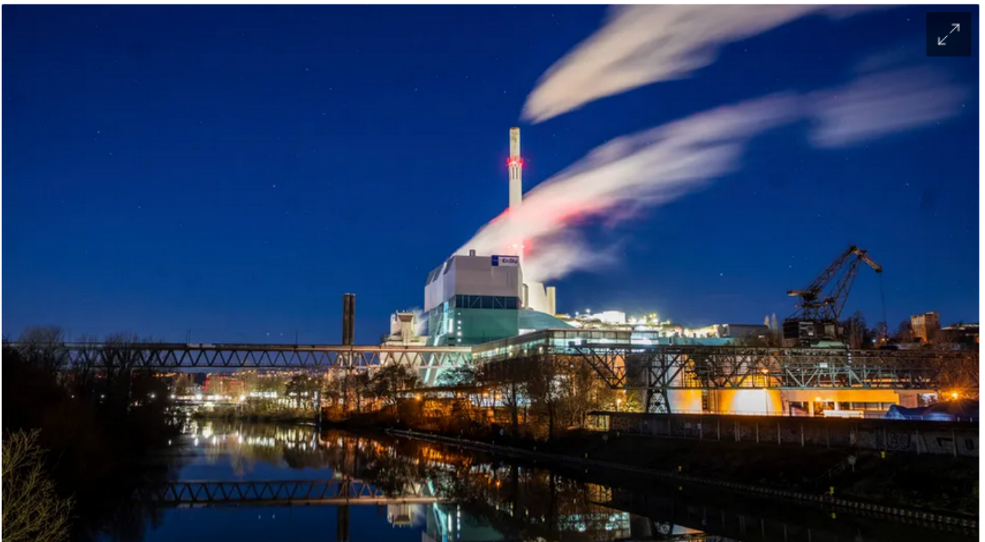
Neuer Gaskraftwerksstandort beim heutigen Kraftwerk in Stuttgart-Münster: »Es soll möglichst wenig im Einsatz sein und nur die Stromlücken aus der wetterabhängigen Erneuerbaren-Erzeugung füllen« Foto: Christoph Schmidt / picture alliance / dpa
