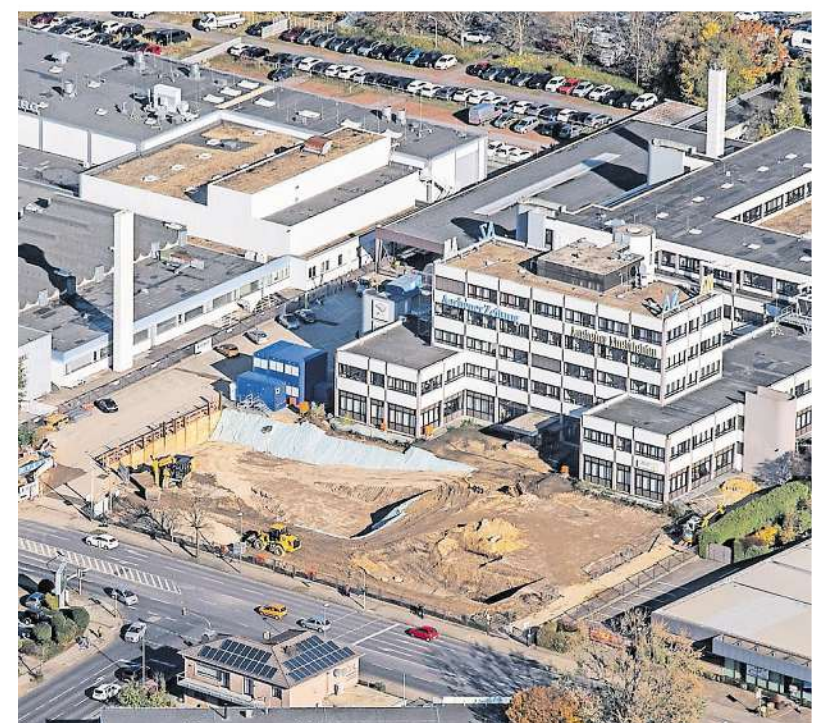
Neubau an der Dresdener Straße 3: In zwei Jahren soll das neue Medienhaus bezugsfertig sein.
